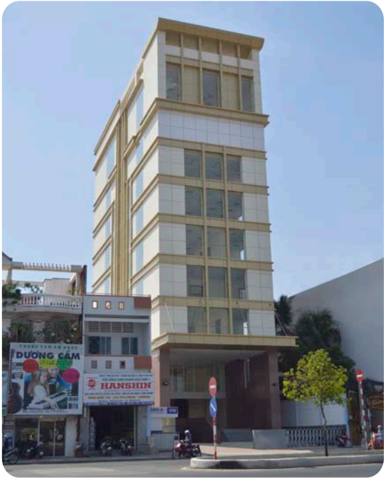
Công trình đường Kinh Dương Vương, Q.6 Kinh Duong Vuong Building
